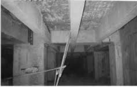
Resim 4 Nervürlü Döşeme İçten Görünümü
