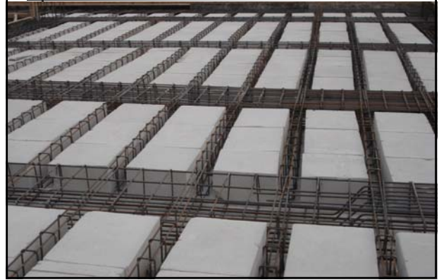
Resim 3 Nervürlü Döşeme Donatı Ve Kalıp Uygulaması
