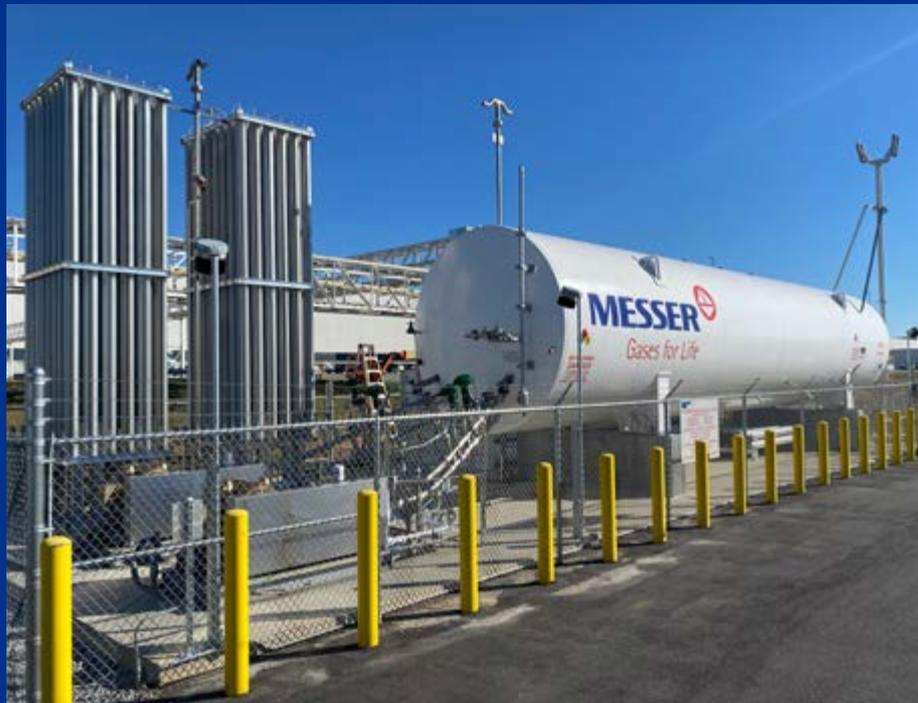
Beispiel einer LH<sub>2</sub>-basierten Betankungsanlage, einschließlich LH<sub>2</sub>-Speicher, Pumpe und Verdampfer (Dispenser nicht abgebildet)
